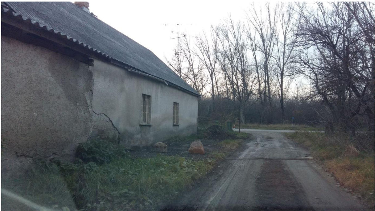
Foto 2. Detail ulice na parcele 68/17 v mieste napojenia na asfaltovú cestu
